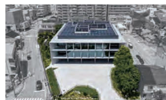
写真2 南面鳥瞰（太陽光発電設備）
